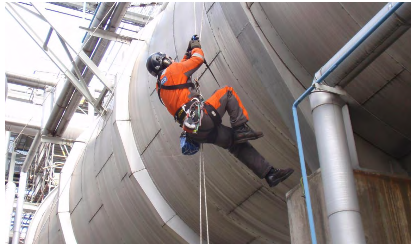
Trabajos verticales en altura
