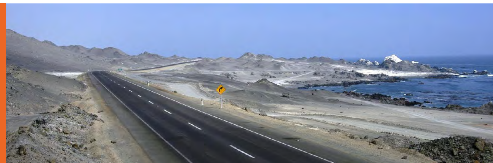
Servicios de inspección de puentes y carreteras
