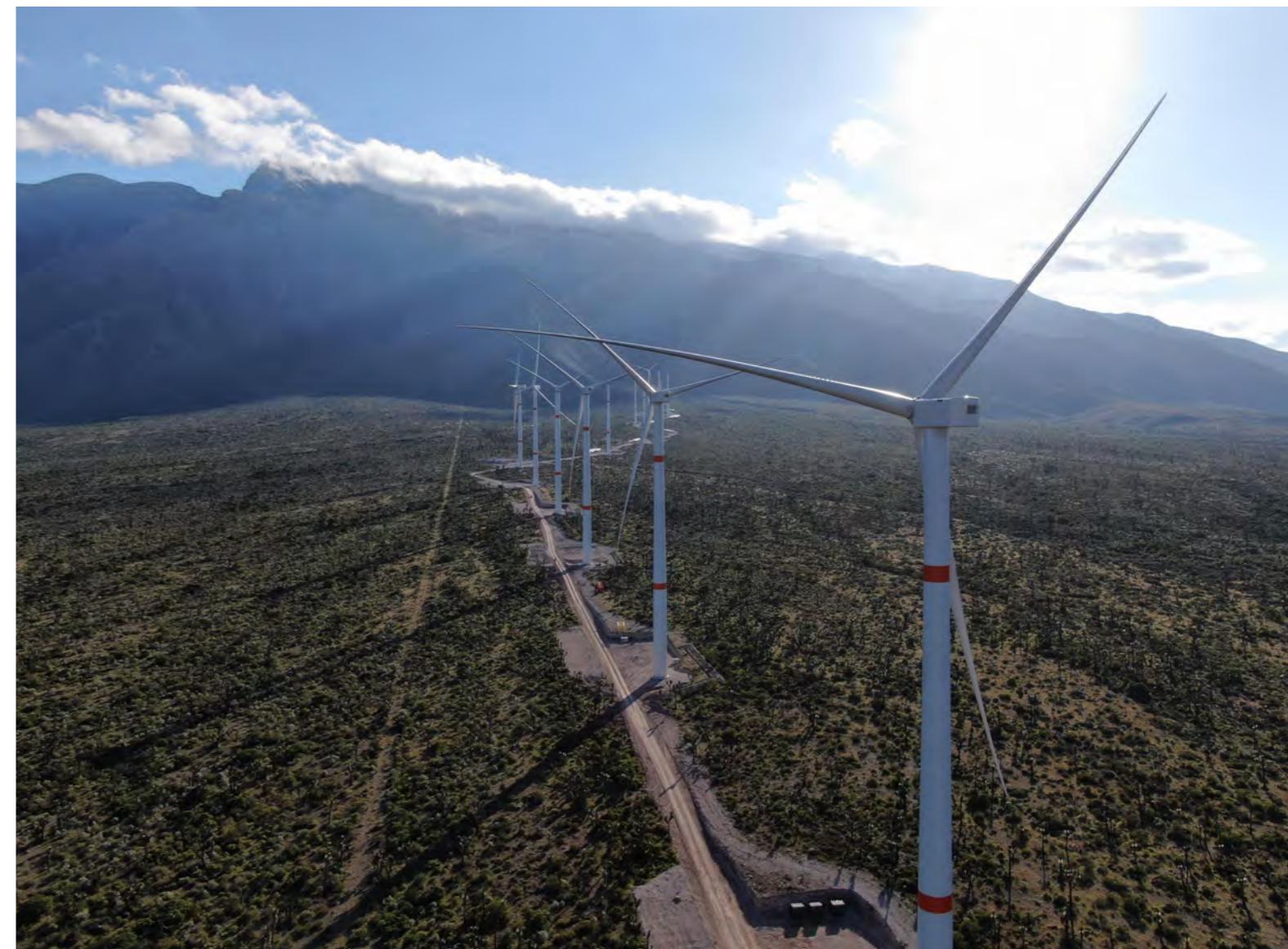
Servicios de eficiencia energética
